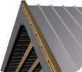
Sch. 24 La bande de rive est installée
